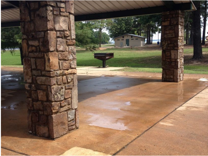
Pavilion — stone columns
